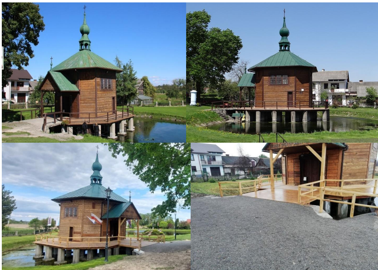
Drewniana kaplica pw. św. Antoniego „Na Wodzie” w Radecznicy przed i po remoncie.
