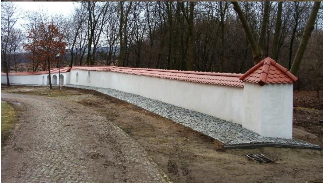
Mury ogrodzeniowe w zespole klasztornym OO. Bernardynów w Radecznicy – przed i po remoncie.
