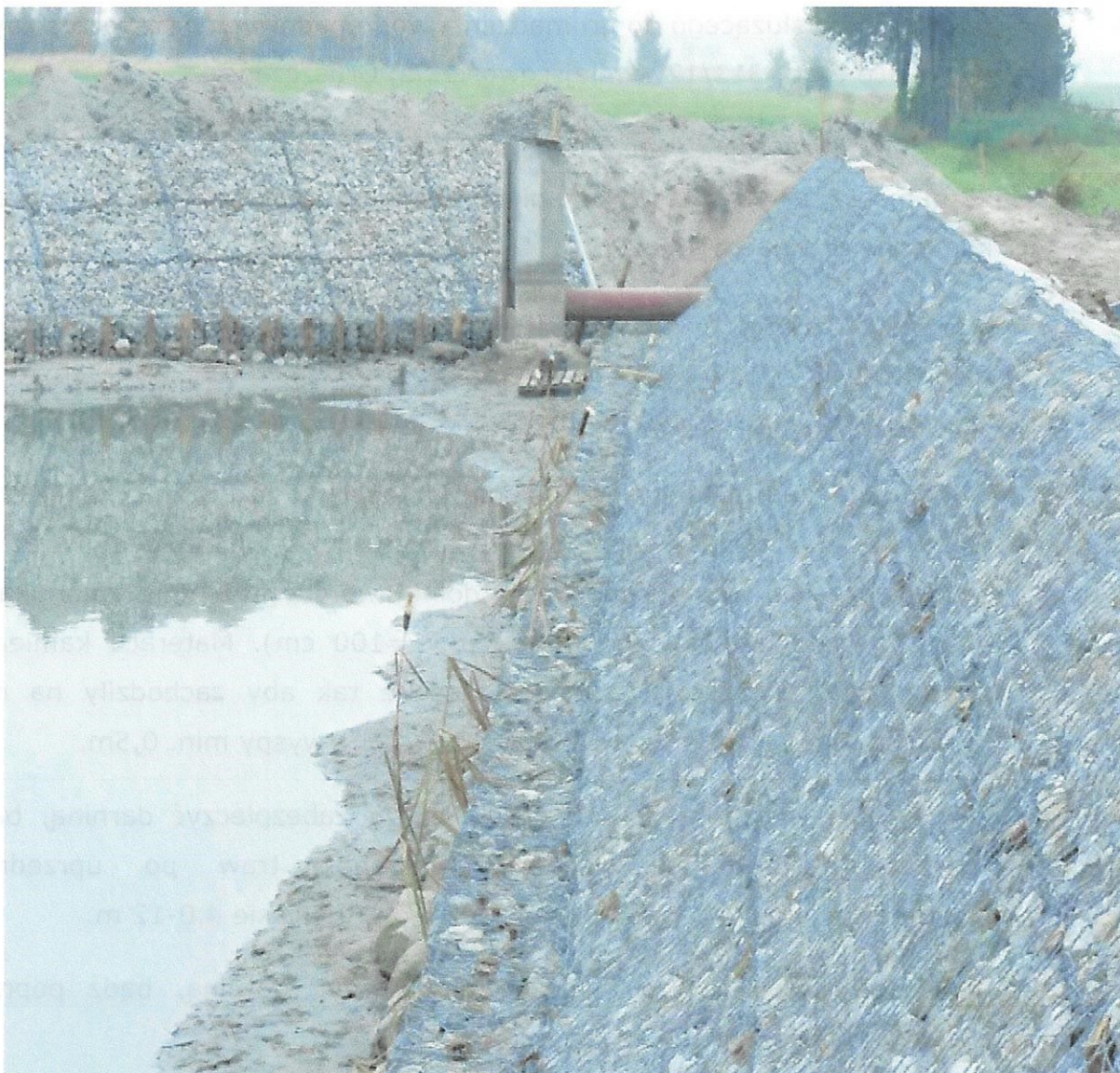
Rys. 2. Materace kamienne (zdjęcie poglądowe).
